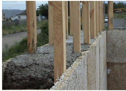
Рисунок 2. Загальний вигляд незнімної опалубки з фібролітових плит
